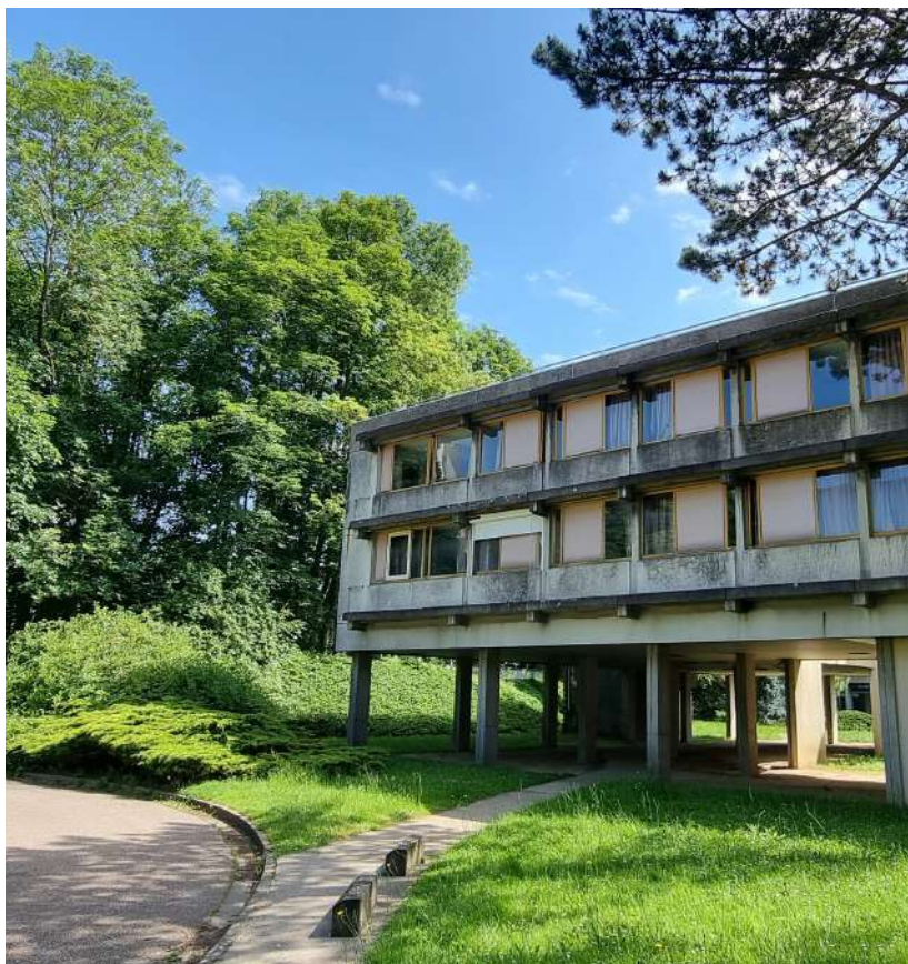
Fig 17. L'architecture en béton de l'extension de l'hôpital Juin 2024 Nathan CURSOUX
