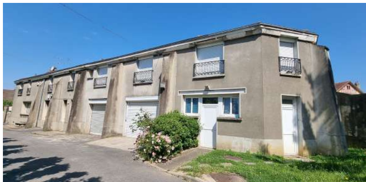
1. Chapelle désacralisée, transformée en logements et espace technique pour le parc
