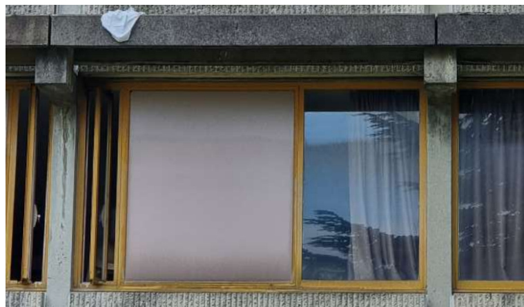
La fenêtre d'une chambre
