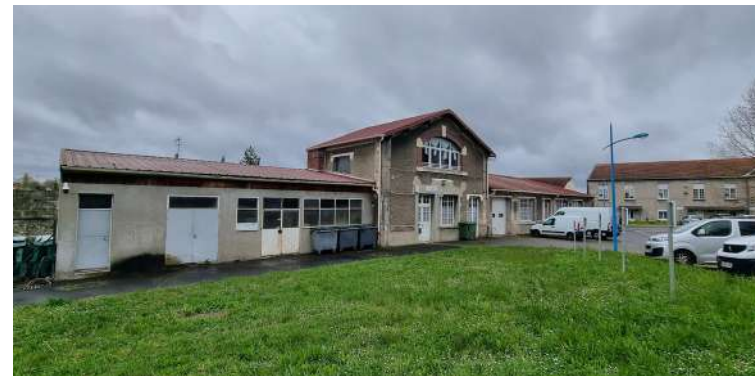
2. Entrée principale du S.M.A.S.H (logements et stockages)
