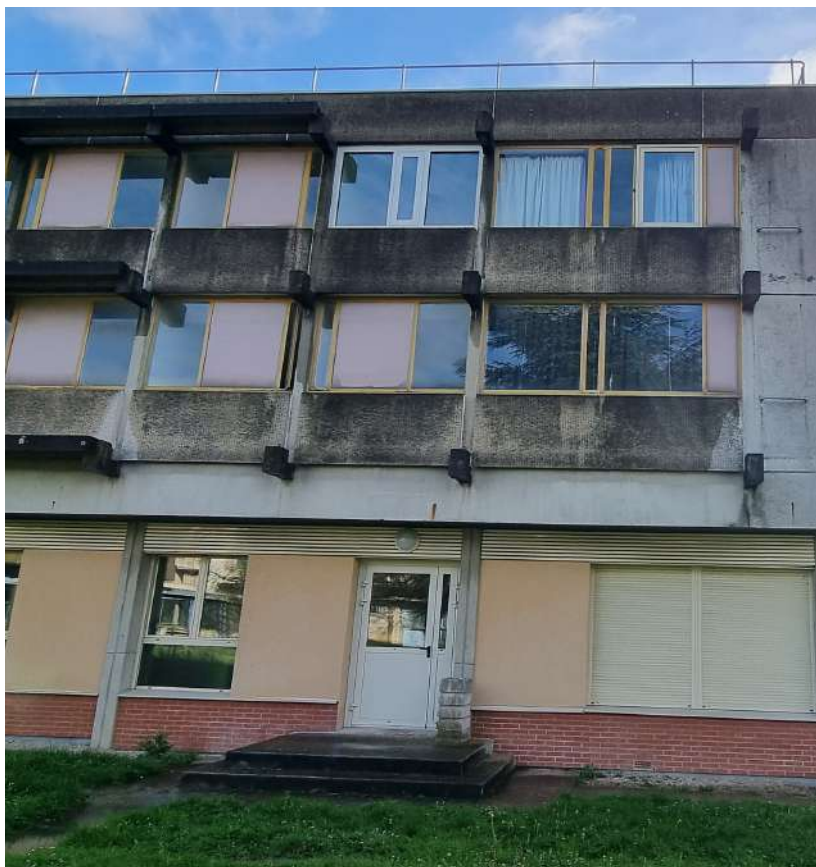
Fig 23. Façade de l'unité de soins H6 sans ses dispositifs d'entretien du vitrage Avril 2024 Nathan CURSOUX
