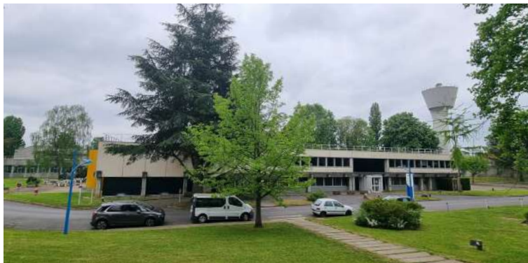
1. Bâtiment administratif (C.M.A.E) à l'entrée du site
